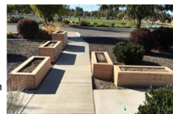
Camas levantadas de varias alturas hechas con tablas de madera
